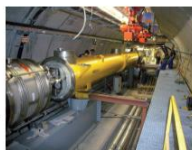
Während der letzten Wartungspause: Einbau des Beschleunigermoduls Nr. 6 in den FLASH-Tunnel. During the last shutdown: Installation of accelerator module no. 6 in the FLASH tunnel.
